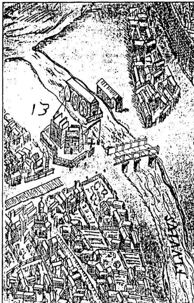
Древнейшая гидросиловая установка в Москве — мельница у устья Яузы. (Деталь г. Сигизмундова» плана 1610 г.).
